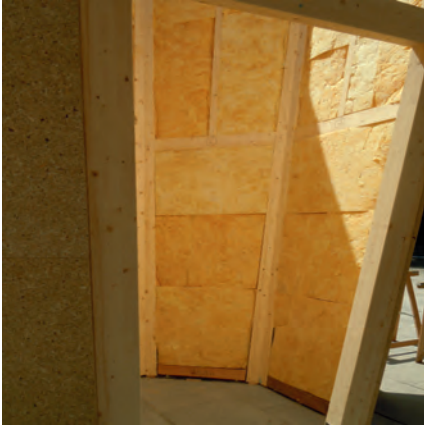
Verkleidung der Holzkonstruktionen mit Verlegeplatten Auskleidung der vertikalen Skulptur mit Schalldämmung
