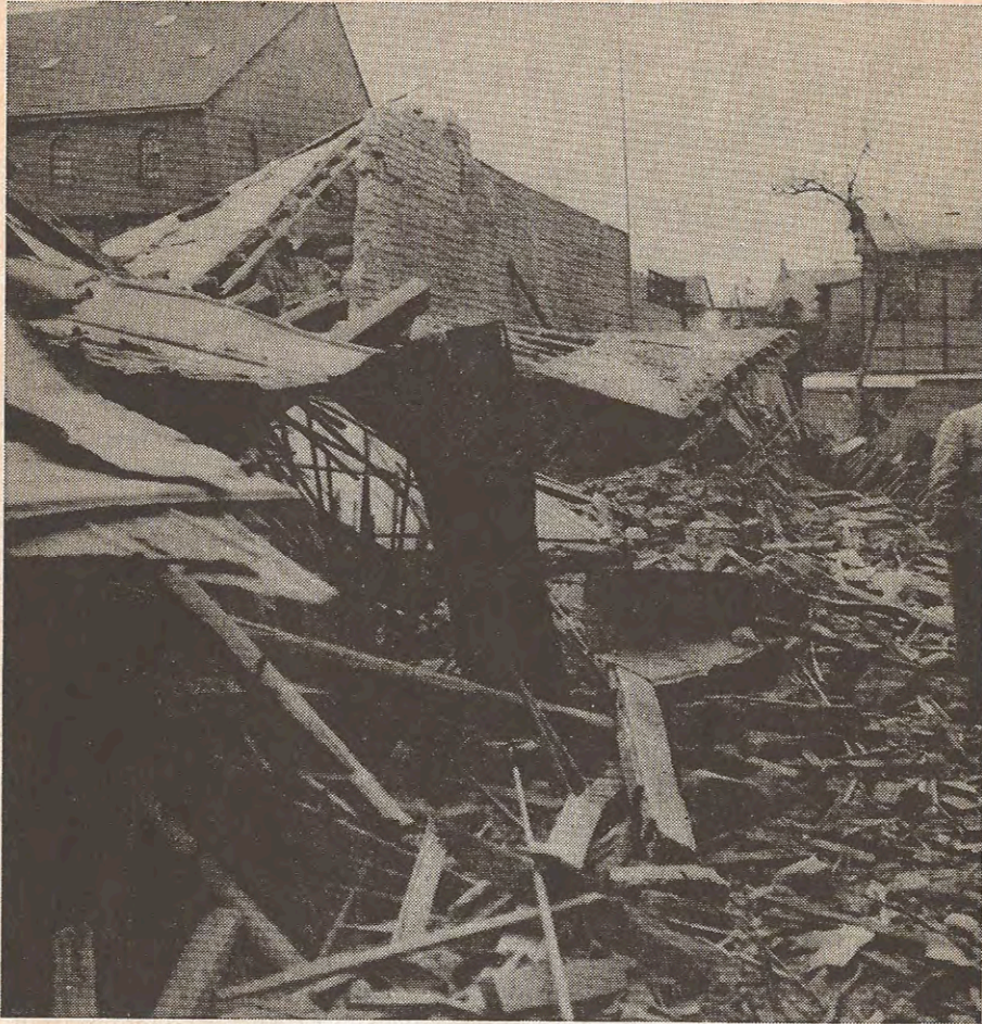
Zerstörte Häuser am Marktplatz.
