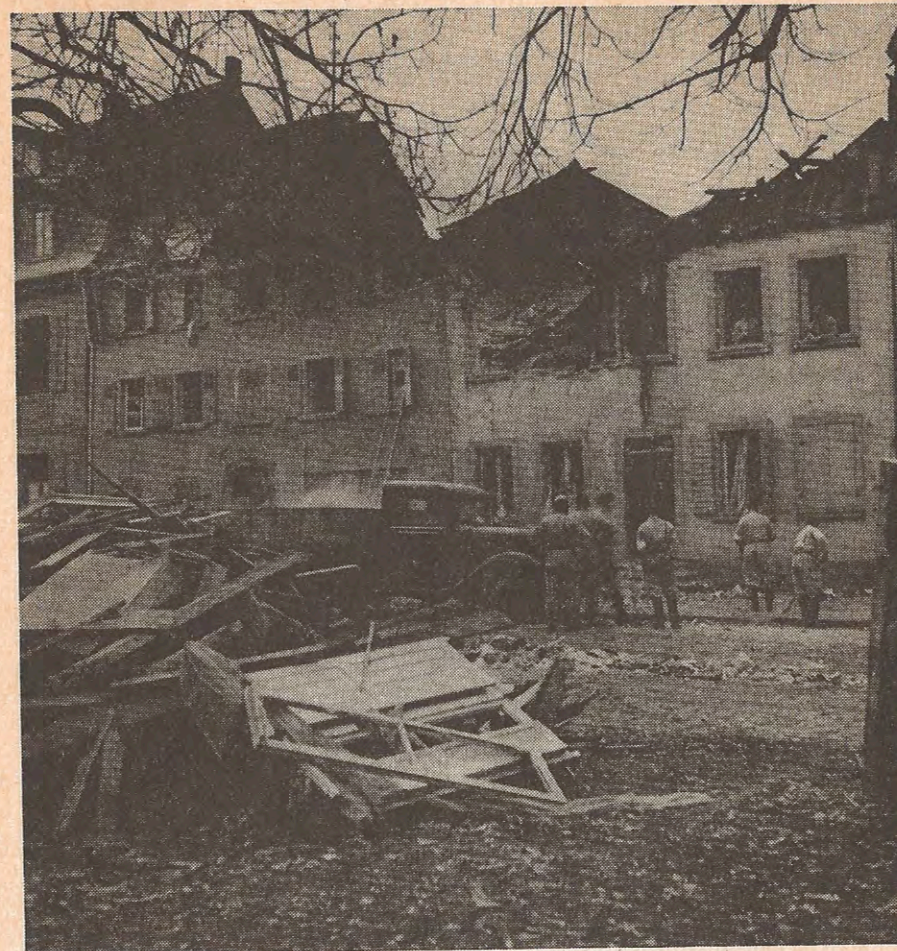
Zerstörte Häuser am Marktplatz.
