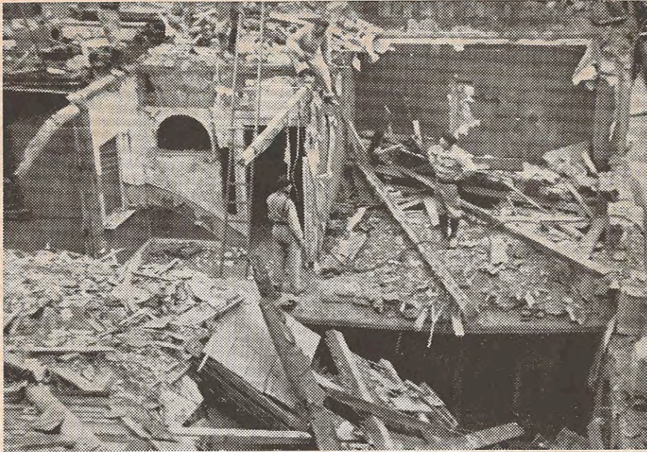
Durch Bombentreffer bis auf die Grundmauern eingestürztes Haus in der Kirchstraße.
